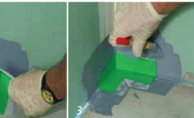
1. Спочатку, куточек слід підготувати, шляхом нанесення шару KÖSTER BD 50 FZ, який повинен охоплювати приблизно 10 см стіни та 10 см підлоги.
