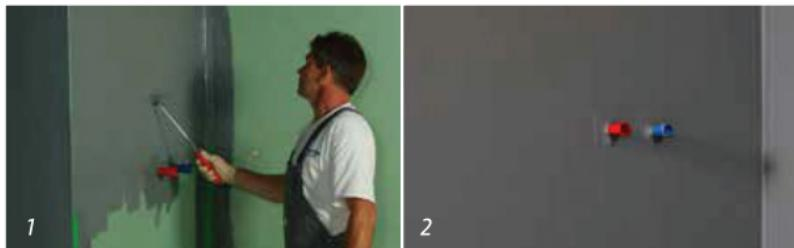
1. KÖSTER BD 50 FZ наноситься за допомогою пензлика або валика. Гідроізоляційні покриття завжди наносяться як мінімум у два шари. Витрата на шар становить приблизно 0,5-0,6 кг / м<sup>2</sup>, що призводить до загального споживання приблизно від 1 до 1,2 кг / м<sup>2</sup>. Час очікування між нанесенням окремих шарів становить не менше 3 годин.
