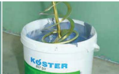
KÖSTER BD 50 Voranstrich FZ наноситься на поверхню пензлем або валиком. Витрати можуть змінюватися в залежності від типу поверхні. Для ґрунтування гіпокартону, ґрунтовки KÖSTER BD 50 Voranstrich FZ розводять водою 1: 3. Витрата ґрунтівки становить приблизно 240 г/м<sup>2</sup>. Більш детальну інформацію про інші субстрати можна знайти в технічній карті.
